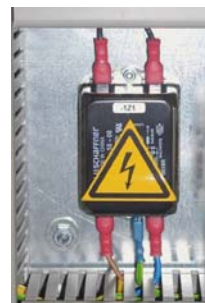
Abb. 3 - 5 Warnaufkleber am Hauptschalter und Netzfilter
