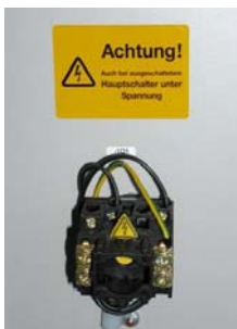
Abb. 3 - 5 Warnaufkleber am Hauptschalter und Netzfilter
